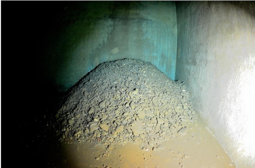
Au pied d' « u canone » un amonçèlement de gravier est relevé d'une hauteur 0.50m. Ils proviennent vraisemblablement des remblais en 0/20 et des terrassements lors des travaux de dallage de la place en 2009/ 2010.
