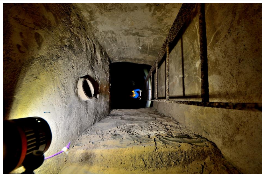
L'accès s'effectue à l'aide d'une échelle (la partie basse est dégradée par une oxydation importante)
